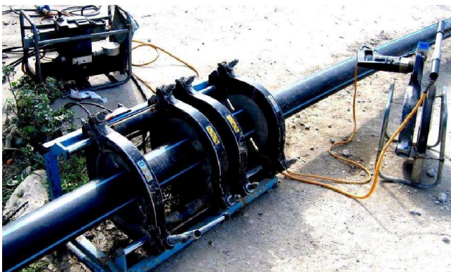
SALDATURA TESTA A TESTA TRA TUBAZIONI
