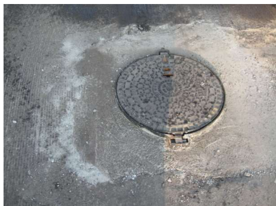
FISSAGGIO DELLA GHISA
