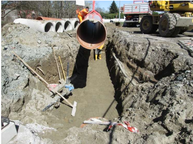
MOVIMENTAZIONE TUBAZIONE IN PVC.
