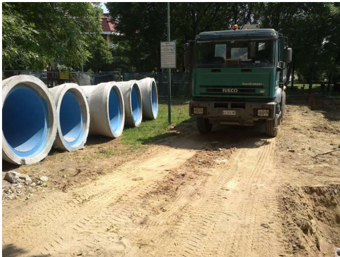
CONDOTTA CON RIVESTIMENTO IN RESINA,
