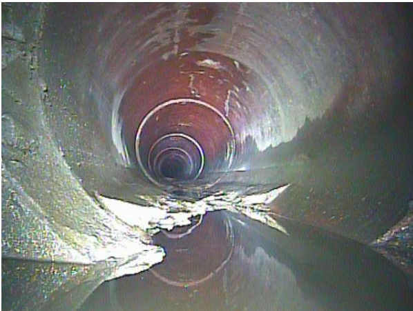
VISTA INTERNA FOGNATURA CON PERISCOPIO
