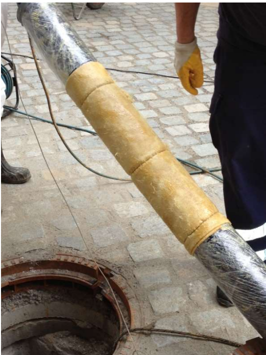
VISTA DELL'INTERVENTO TERMINATO
