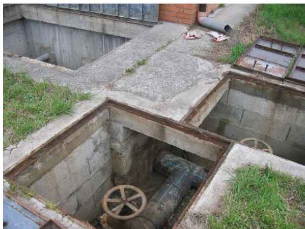
INCROCIO TRA TUBAZIONI IN PEAD
