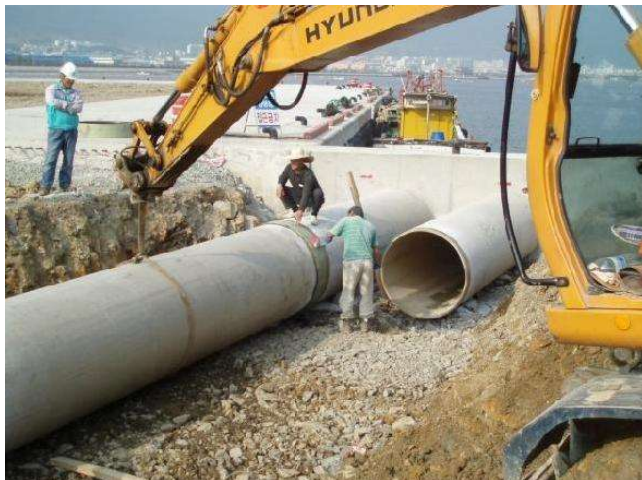
POSA IN TRINCEA DELLA TUBAZIONE
