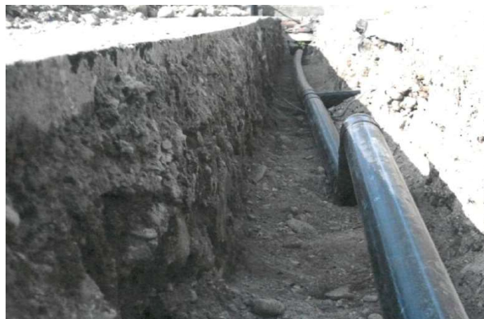
POSA DI UNA TUBAZIONI IN PEAD
