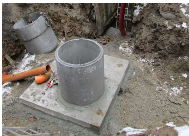
POSA DEL PASSO D'UOMO Ø 800 mm
