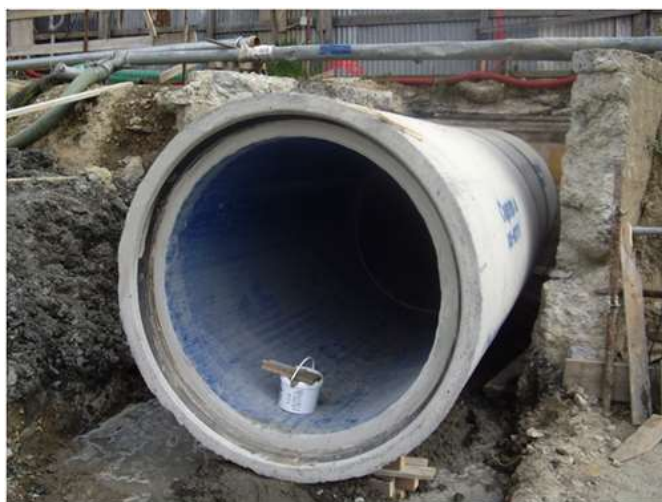
CONDOTTA RIVESTITA CON POLIETILENE.
