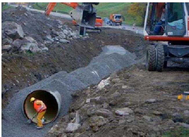
RINTERRO DELLA TUBAZIONE
