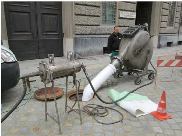
CALZA IMMESSA NELLA CONDOTTA
