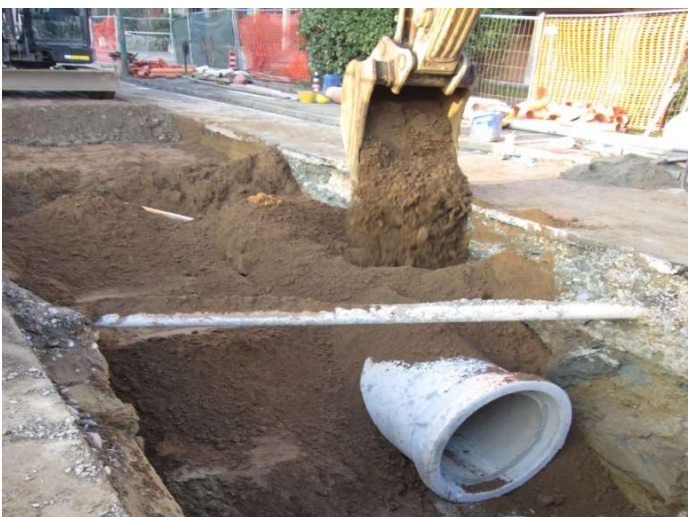
RIEMPIMENTO VANO SCAVO.
