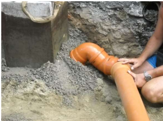
REALIZZAZIONE CON GETTO IN OPERA
