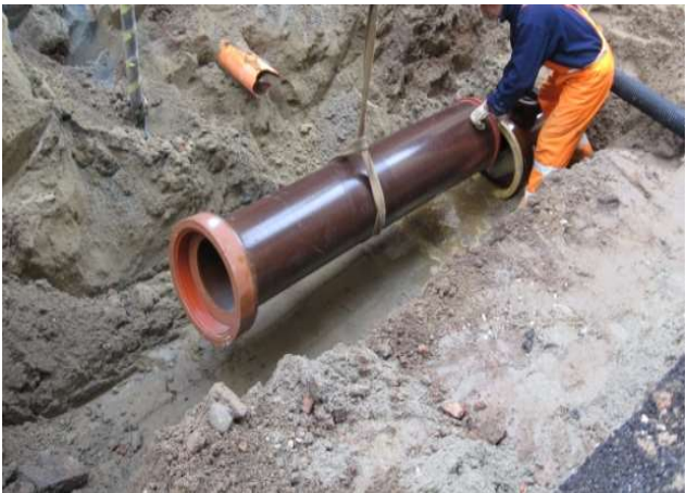
CALO DEL TUBO IN TRINCEA
