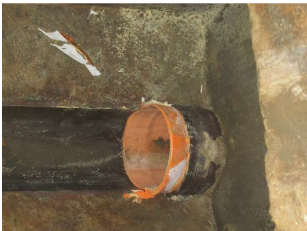
VISTA DELL'INTERVENTO TERMINATO
