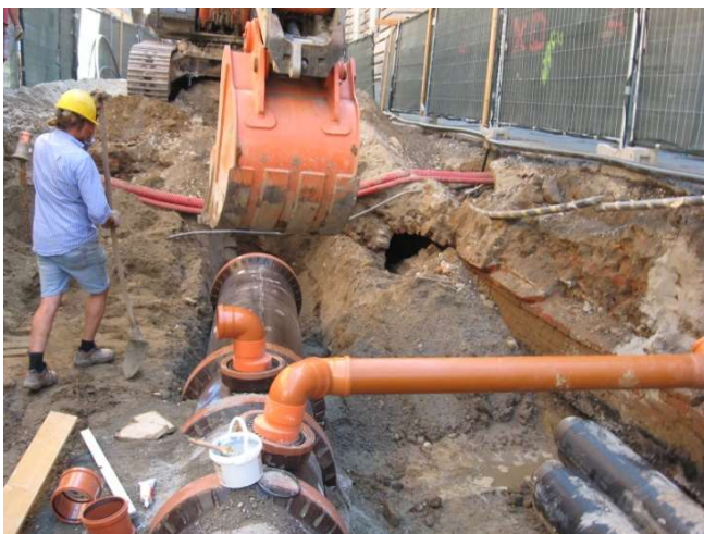
VISTA DI UN ALLACCIO APPENA REALIZZATO.
