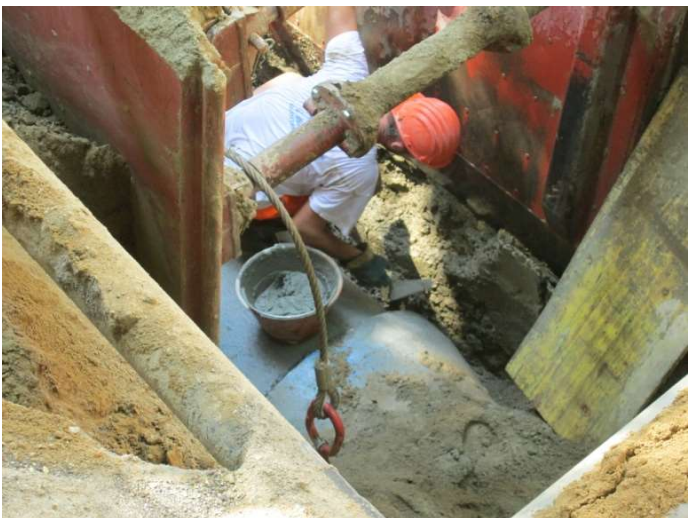
SIGILLATURA GIUNTO ESTERNO CON EMACO
