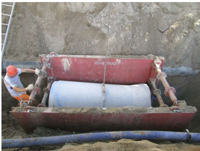
CALO DEL TUBO IN TRINCEA
