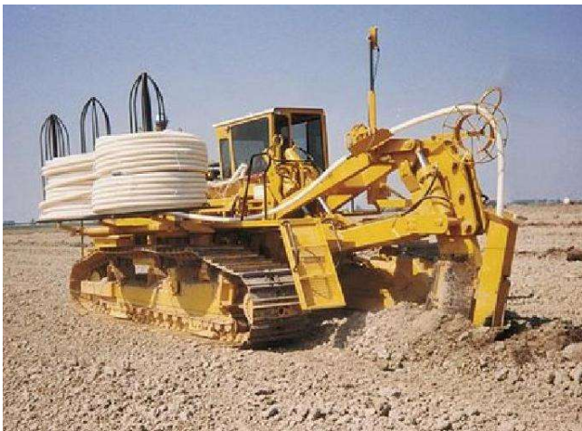
POSA DELLA TUBAZIONE CON METODO AD ARATRO
