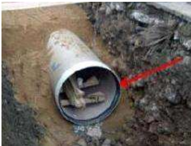
RINTERRO DELLA TUBAZIONE
