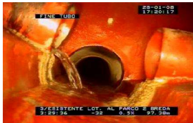
VISTA INTERNA FOGNATURA
