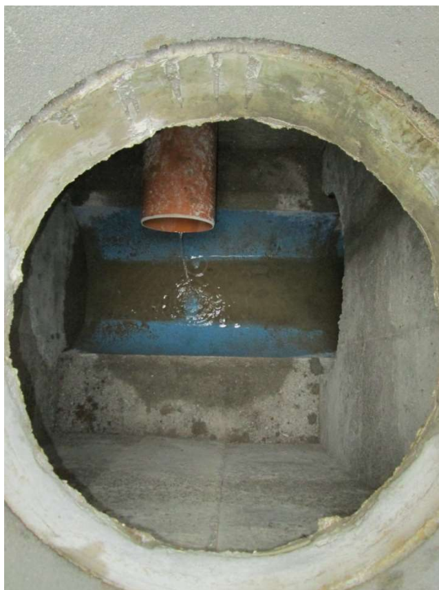
VISTA INTERNA SU TUBO PASSANTE
