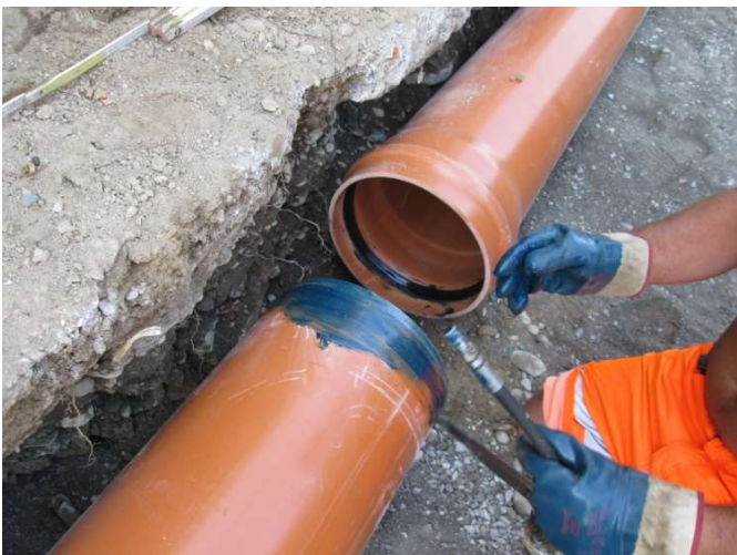
LUBRIFICAZIONE DEL TUBO PRIMA DELL'INNESTO.
